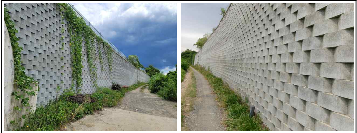
【사진 9.3.2】 전면부 전경
