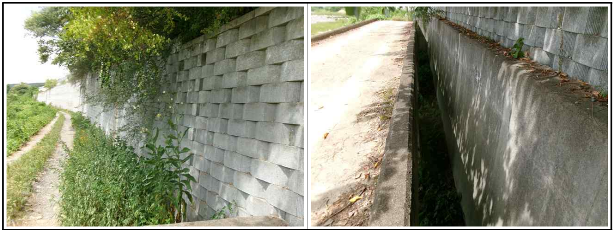
【사진 9.3.1】 지반, 기초부 전경
